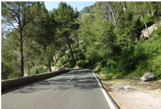
Fig. 7. Tram amb mur de contenció de pedra calcària.
