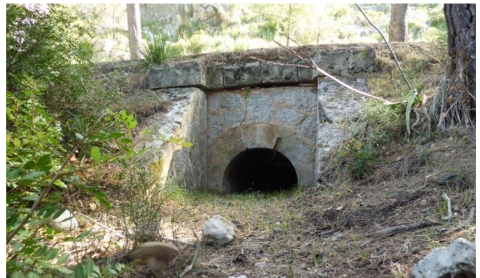
Fig. 5. Sortida d'un drenatge transversal.
