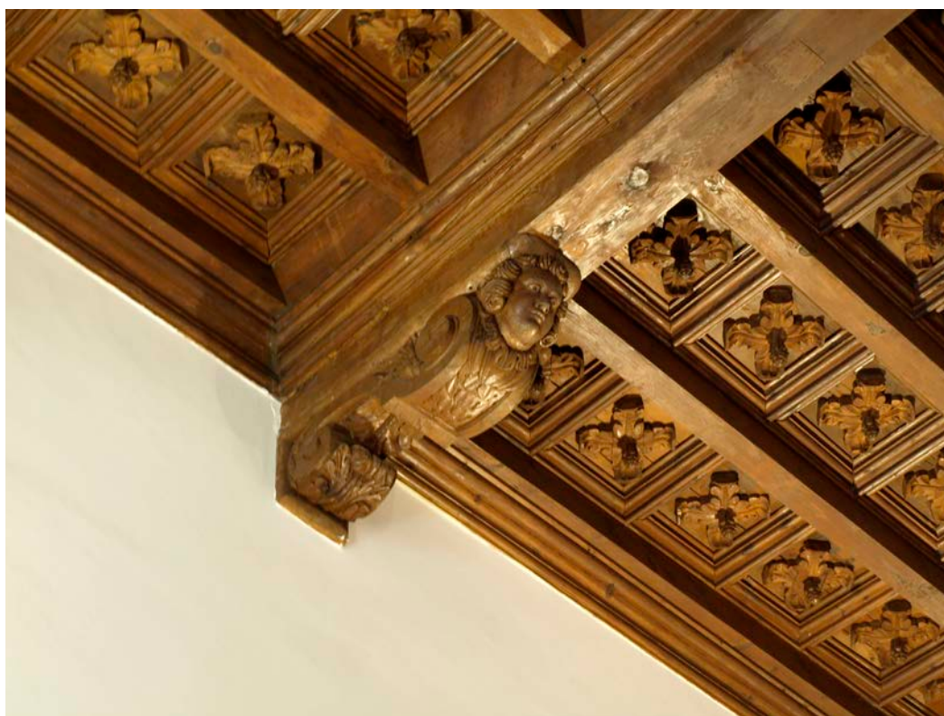
Figura 2. Detall de l'enteixinat ( font : Joana A. Ordines)
